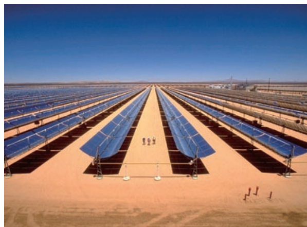
砂漠地帯に設置したトラフ型の太陽熱発電設備。曲面鏡の上のパイプに集光して中のオイルを加熱する
