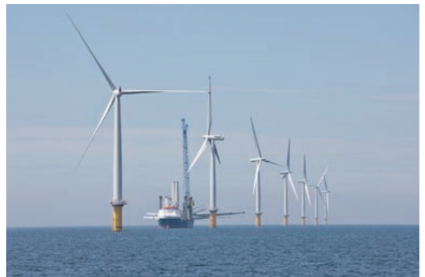
英国の洋上に建設中の着床式の洋上風力発電設備
