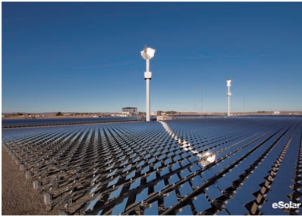
タワートップ型の太陽熱発電設備。ヘリオスタットで日光を反射させ、タワートップに集光する
